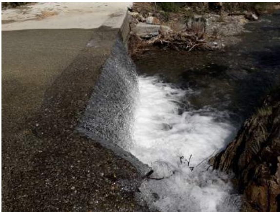
Point de prélèvement – Mine 2
