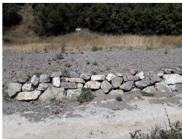
Photo 11 : Plateforme Marty en période d'étiage du Grésillou (25/08/20)
