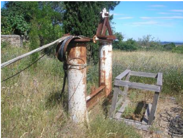
Photo 1 : Tuyaux au Panneau Sud
